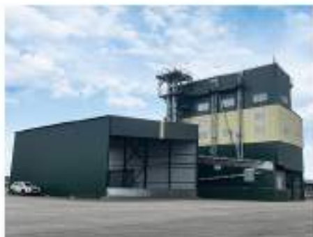
Сушильно-сортировальный комплекс, Кемеровская область
